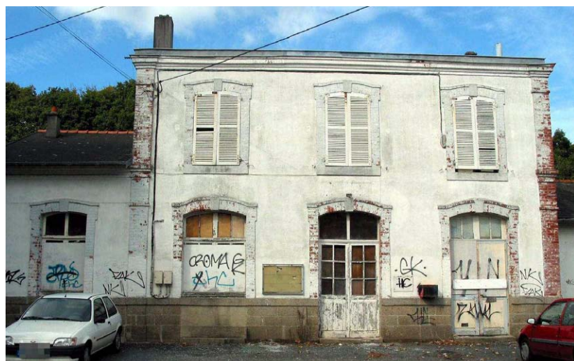
S'il a un temps été question de la détruire, la vieille gare (1865) restera finalement debout. Après rénovation, elle accueillera, à partir de septembre, une école de danse contemporaine dirigée par le chorégraphe Herwann Asseh.
